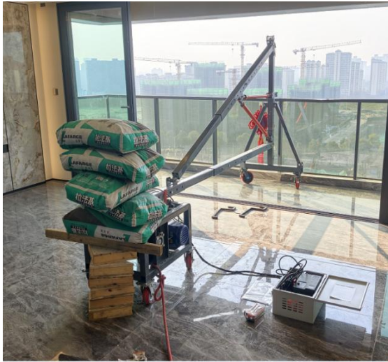
图4 曾国富复原吊窗机搭建图
